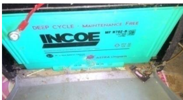
Gambar 6. Aki Deep Cycle-MF Di Pulau Geranting
