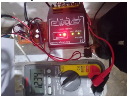
Gambar 15. Pengujian Tegangan Inputan Generator
